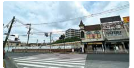
現在工事中の百合ヶ丘駅前建設現場(左側)。新店舗の1階には処方せん受付が併設される予定。生鮮食品売り場は1・2階に分かれ、野菜・肉・魚・惣菜などを販売予定
