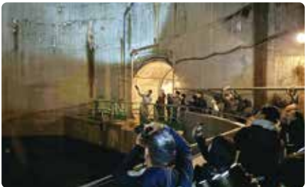
恩廻公園調節池、地下約50mの巨大トンネル見学の様子
