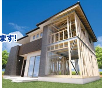
モデルハウスは地震に強い「テクノストラクチャー構造」を利用しています。その構造の一部を確認できます。
